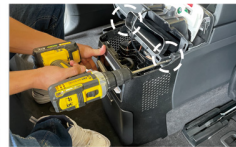
28.把冰箱推进安装 装回螺丝固定
