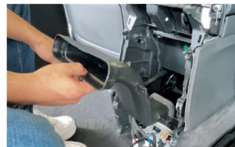
21.装上配件中的空调导风管
