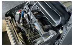
26.原车三条信号线(从冰箱左侧下方穿过)与空调控制面板上对应的电线对接连接
