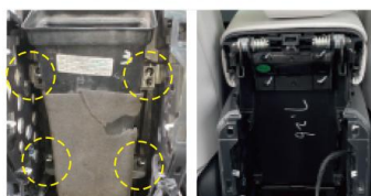
5. 拧出4颗螺丝，拆除原车空调导风管
