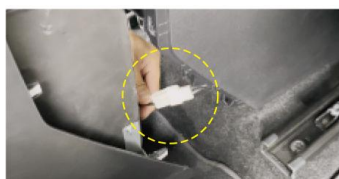
16. 将一分二电源线尾端连接冰箱下方白色接口
