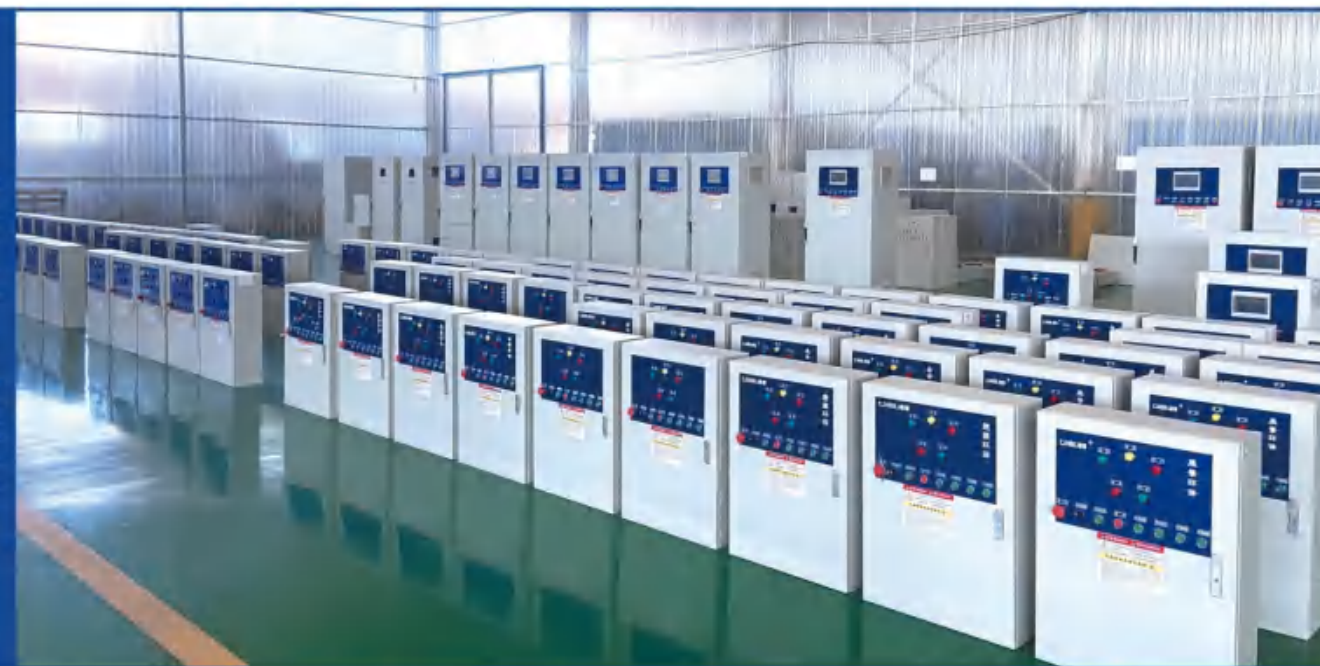
液压、电控车间
