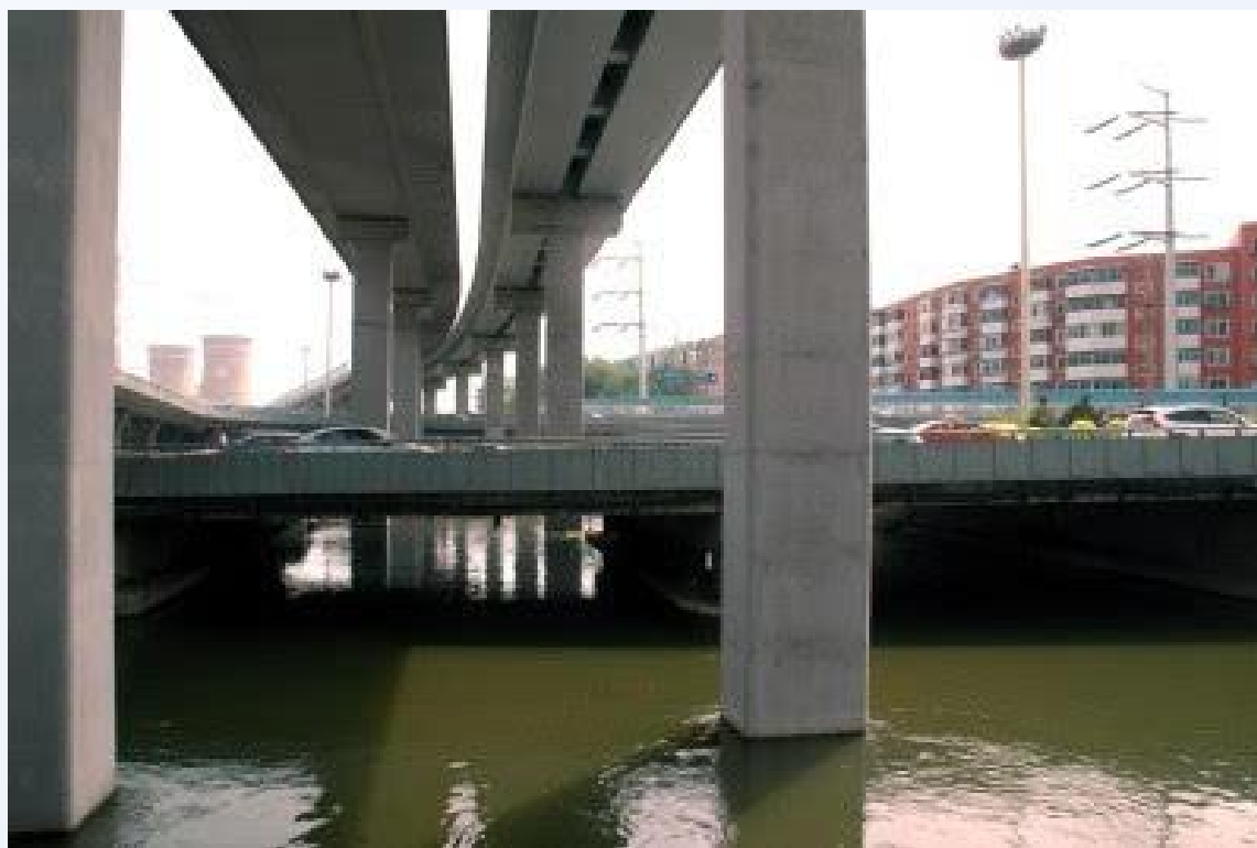
井冈山1号盾构机安全穿过桥河和居民楼
