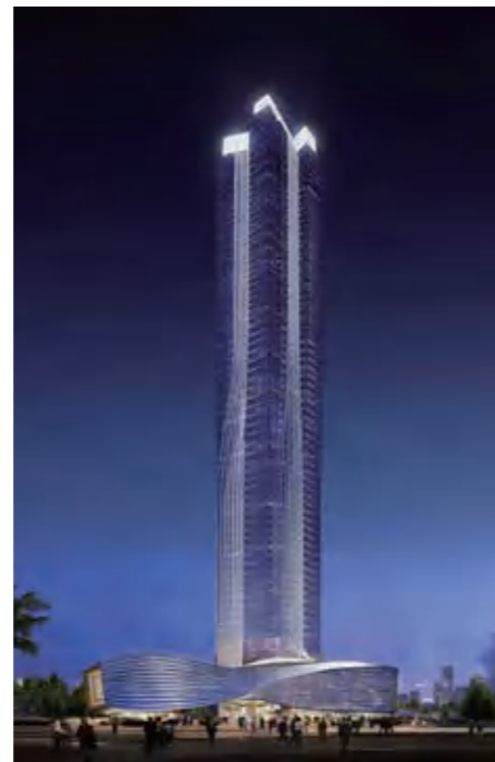
珠海横琴国际金融中心——珠海第一高楼
