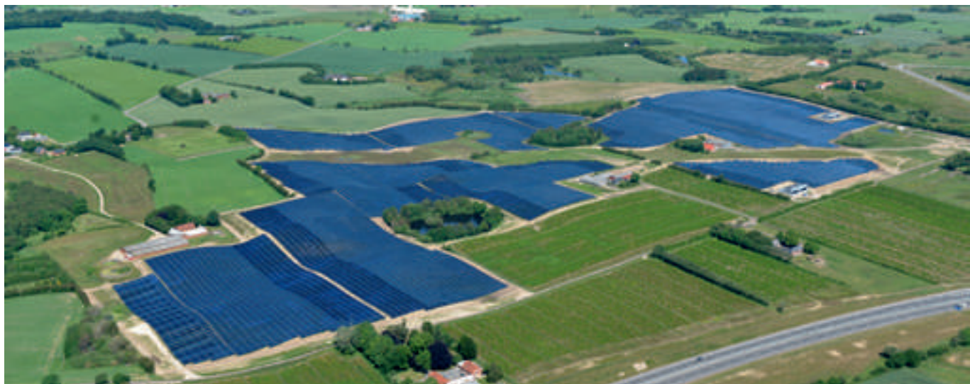
位于锡尔克堡郊区的世界最大的太阳能供热厂对整个区域供热系统起到了优化作用。两个板块之间的绿色区域留出未用，目的是为未来建设公路留出空间。
