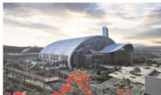
广西南宁环保发电厂 (2000吨/天)
