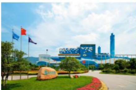
苏州垃圾发电项目
