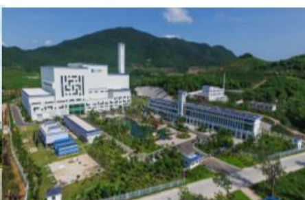
三亚垃圾发电项目
