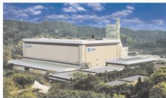
重庆丰盛环保发电厂 (2400吨/天)
