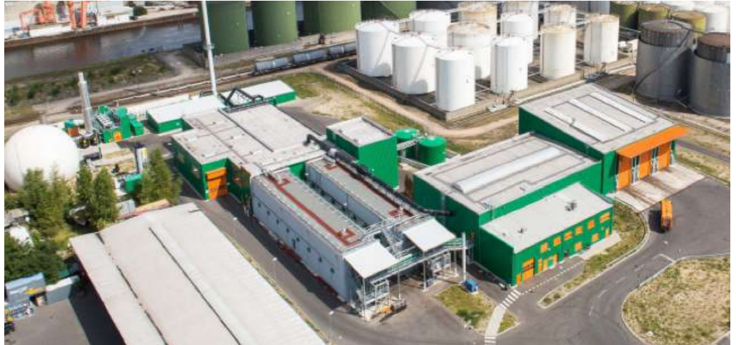
图 5： BSR公司厂区图，左上角为沼 气净化提纯装置
