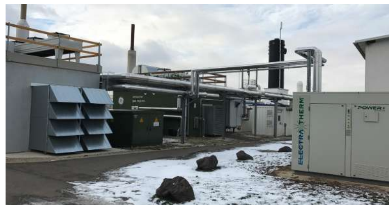
图 8: Grabsleben村沼气厂的热电联产机组（左）ORC机组及沼气净化提纯装置（右中/右上）
