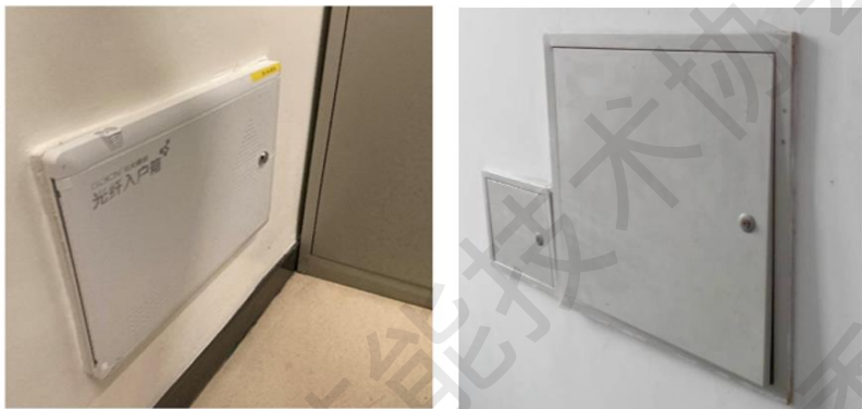
图 3-17 信息箱安装示意
