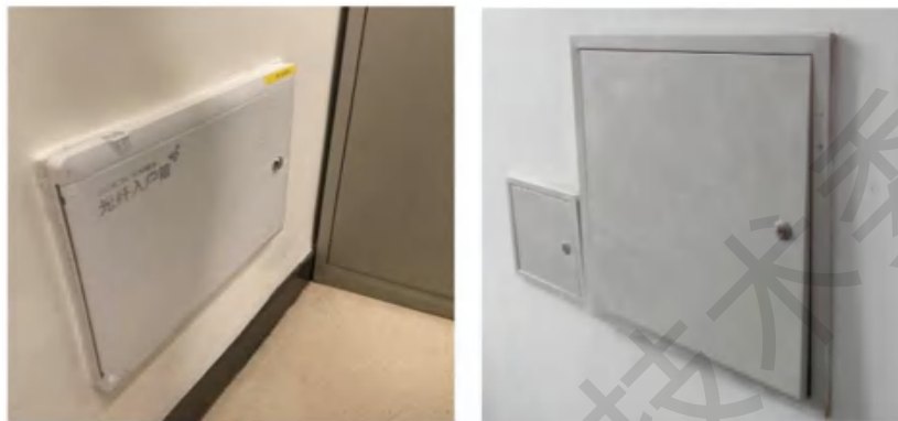
图 2-11 信息配线箱嵌墙暗装的安装方式
