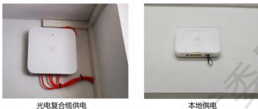
图 2-13 支持 Wi-Fi 的盒式 ONU 挂墙安装方式
