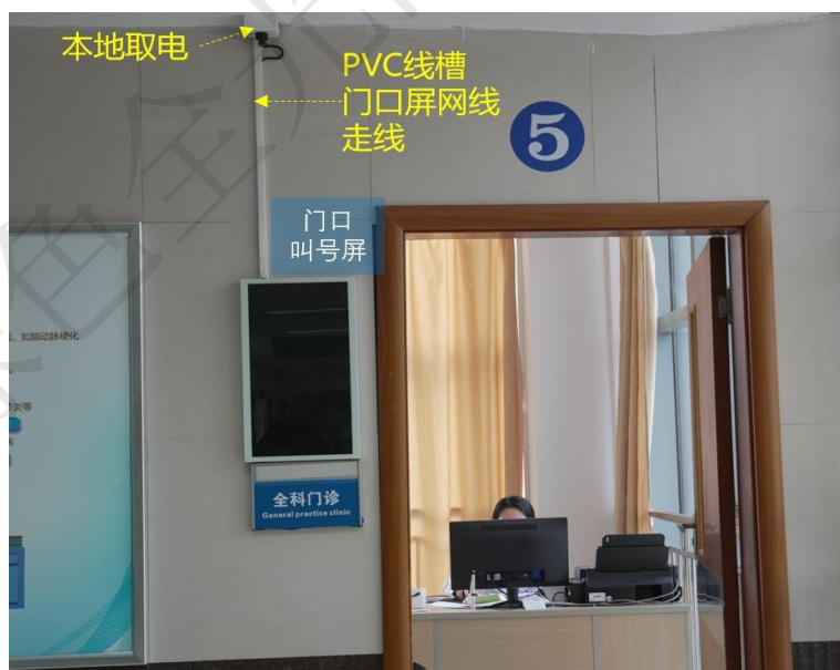
图 3-10 诊室门口叫号屏改造及走线
