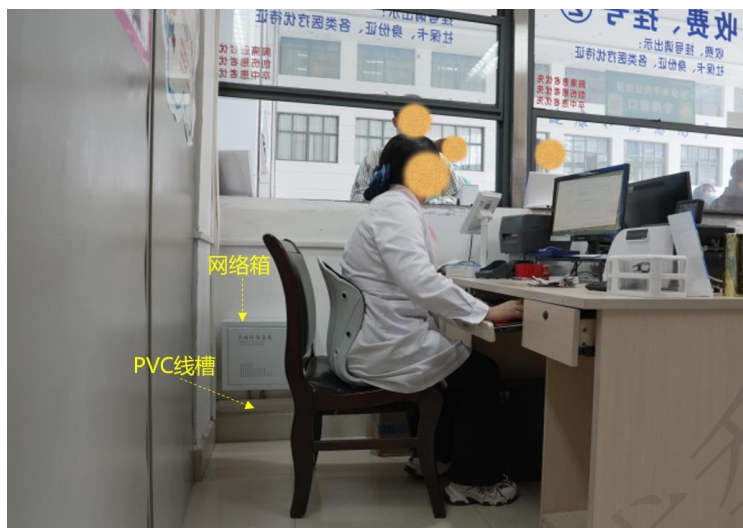
图 3-20 挂号收费处信息配线箱安装及走线
