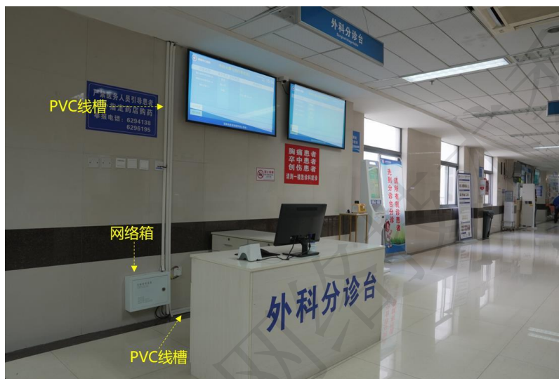
图 3-17 分诊台 F5G 全光网改造
