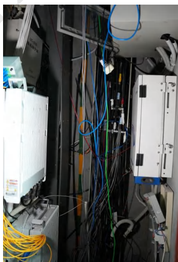
图 1-9 弱电间的空间及散热条件有限
