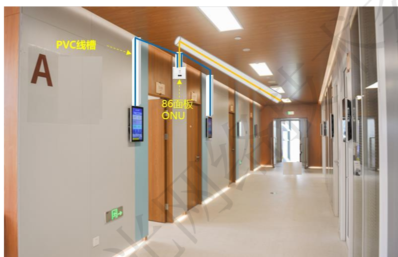
图 3-11 诊室采用 86 型面板 ONU 进行改造
