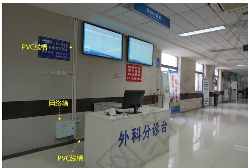
图 3-17 分诊台 F5G 全光网改造
