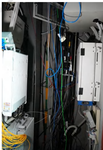
图 1-9 弱电间的空间及散热条件有限
