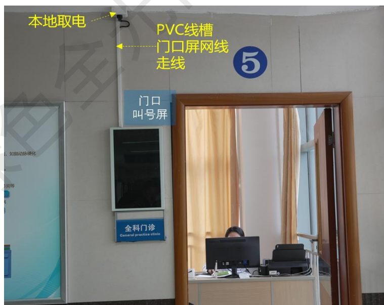
图 3-10 诊室门口叫号屏改造及走线
