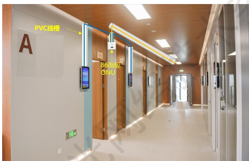
图 3-11 诊室采用 86 型面板 ONU 进行改造
