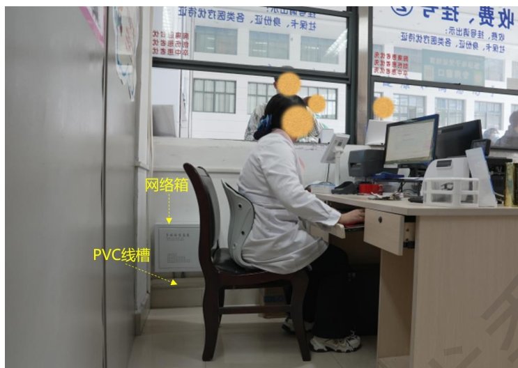
图 3-20 挂号收费处信息配线箱安装及走线
