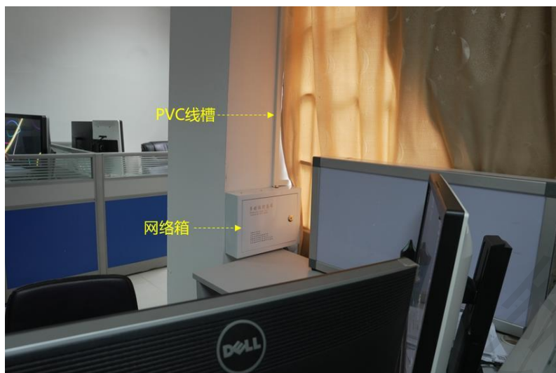
图 3-24 阅片室采用信息配线箱改造
