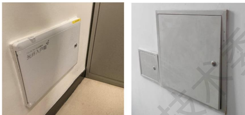
图 2-11 信息配线箱嵌墙暗装的安装方式
