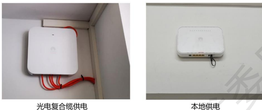
图 2-13 支持 Wi-Fi 的盒式 ONU 挂墙安装方式
